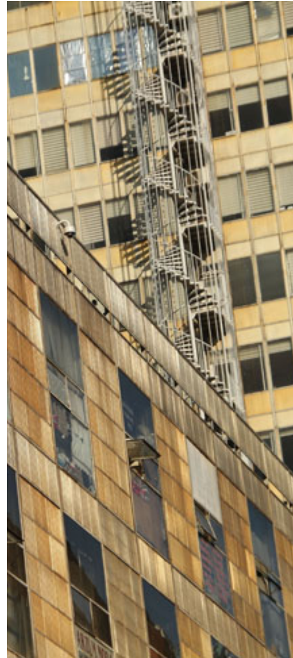
Anafartalar arŐısı’nın yangın merdivenleri
